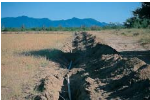
かんがい用パイプ敷設中の10ヘクタール実証展示圃場
