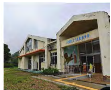
廃止された保育園を活用した八頭町の「まちづくり委員会」の活動拠点(下私都地区)
