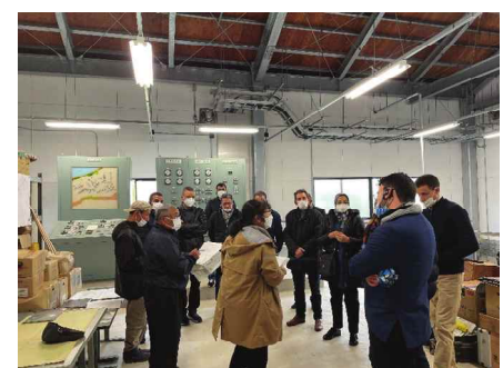
モロッコ人技術者は、鳥取市・福部土地改良区の揚水ポンプ場施設を見学し、鳥取における農家共同によるかんがい事業や施設の維持管理手法を学びました。
