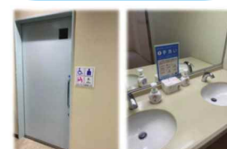
オールジェンダートイレ設置 生理用品の配置
