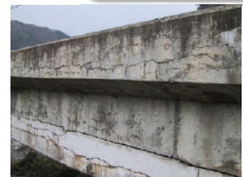
ASRIによるコンクリート橋の劣化事例
