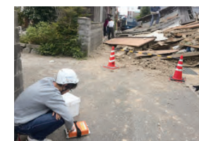
写真 平成 28 年鳥取県中部の地震
