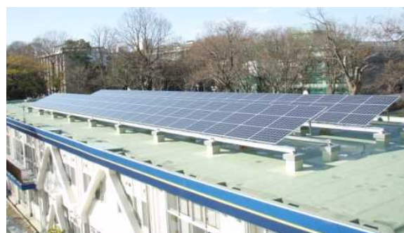
設置の状況 (大学会館)
