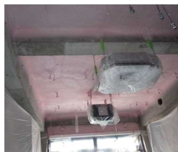
天井・壁面の高断熱化
