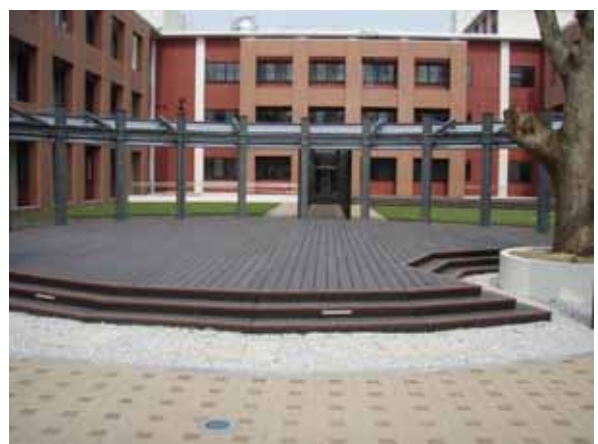
改修工事で設置した屋外デッキ
