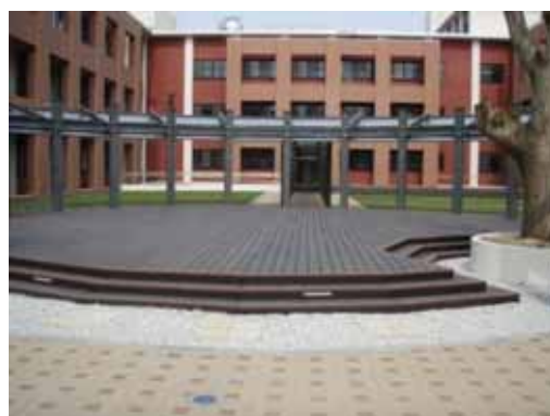
改修工事で設置した屋外デッキ
