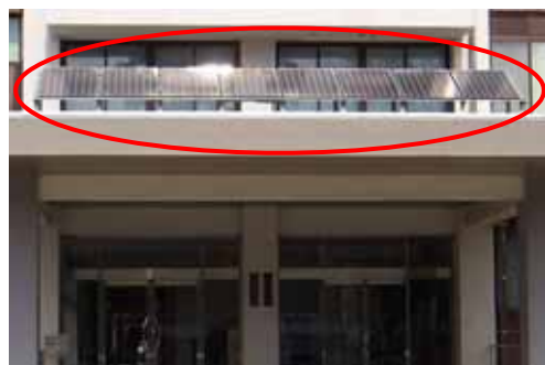
設置の状況 (工学部玄関)
