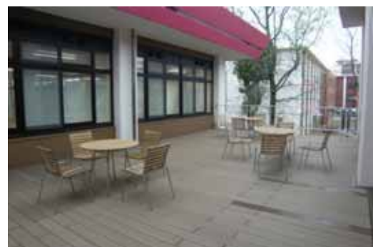
改修工事で設置した屋外デッキ
