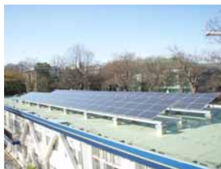
設置の状況（大学会館）
