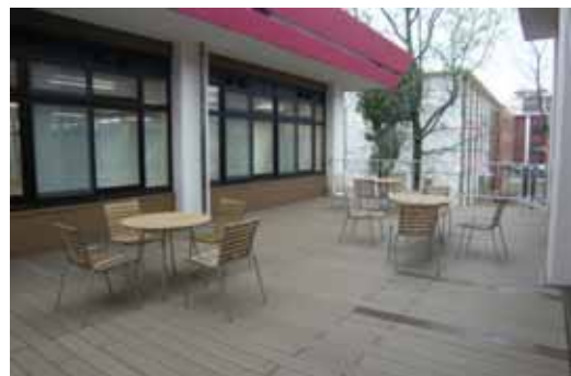
改修工事で設置した屋外デッキ
