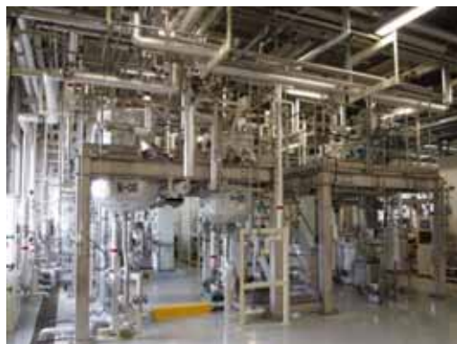
バイオエタノールを生産するための製造プラント
