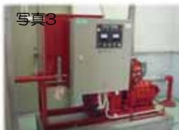
火災初期消火のための屋内消火栓設備に水を供給するためのポンプです。
