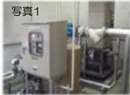
法律に定められた水質を確保するため、滅菌装置による塩素注入を自動制御で行っています。
