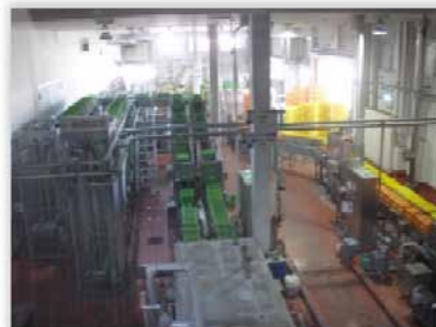
工場内の設備
