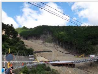
2011年12号台風による大規模崩壊 (奈良県川上村)
