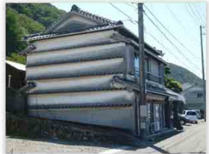
漆喰の壁を雨から守る水切り瓦
