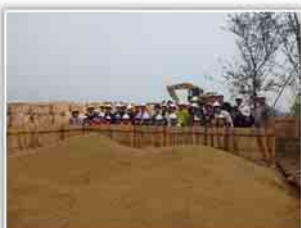
5. 敷地造成工 完成
