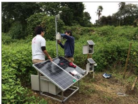
猪捕獲罠監視システム設置（鹿野町）
