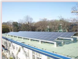
設置の状況(大学会館)
