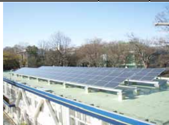
設置の状況 (大学会館)
