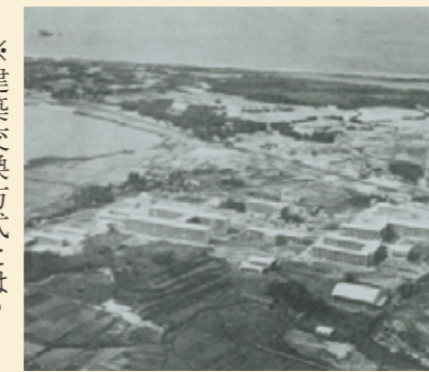
整備が進む学舎
