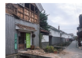
倉吉市白壁土蔵群 地震直後の様子
