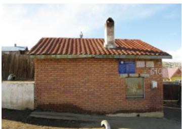
ゲル地区に設置された上水供給施設「ウォーター・キオスク」
