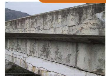
ASRIによるコンクリート橋の劣化事例
