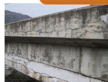
ASRIによるコンクリート橋の劣化事例
